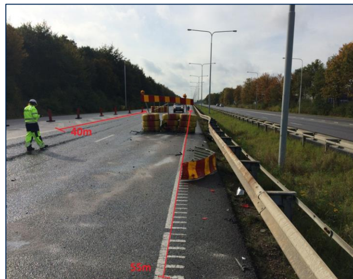
3:e man dödsolycka Helsingborg 2014-10-09, Däckbuffert flyttas 40 m Inga bromsspår framför bufferten
